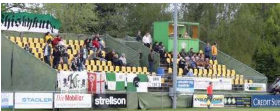
Die Stahlrohrtribüne auf dem Hafenareal
